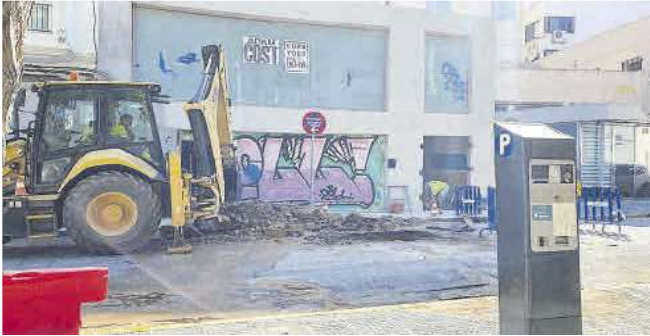
Operarios de Aqualia, ayer por la mañana arreglando la avería.
